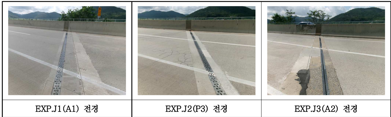
【사진 7.3.16】 신축이음장치 전경
