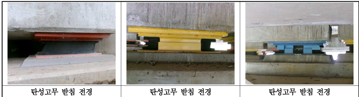
【사진 7.3.12】 교량받침 전경
