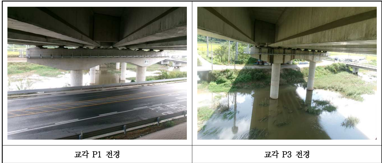
【사진 7.3.10】 교각 전경
