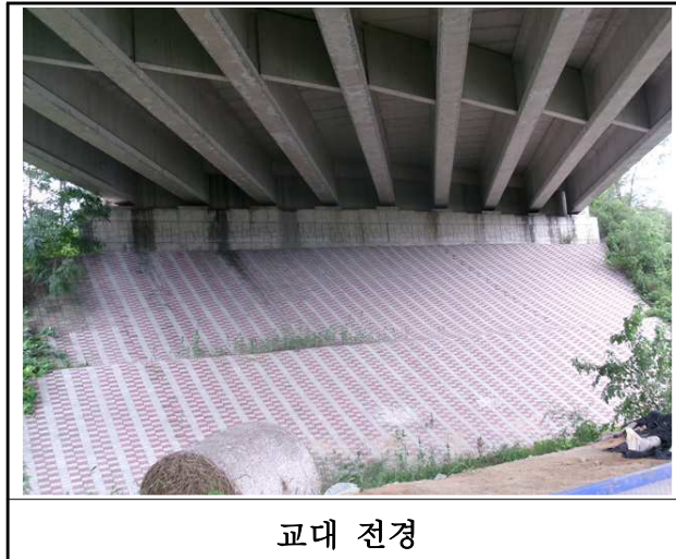
【사진 7.3.8】 교대 전경
