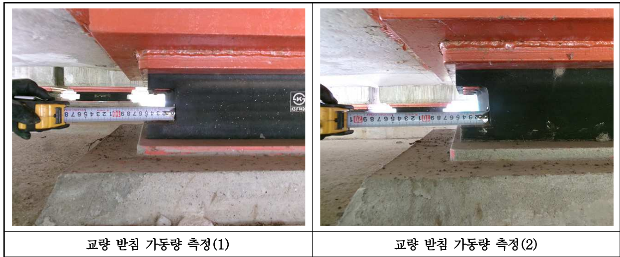
【사진 7.3.15】 교량받침 이동량 측정
